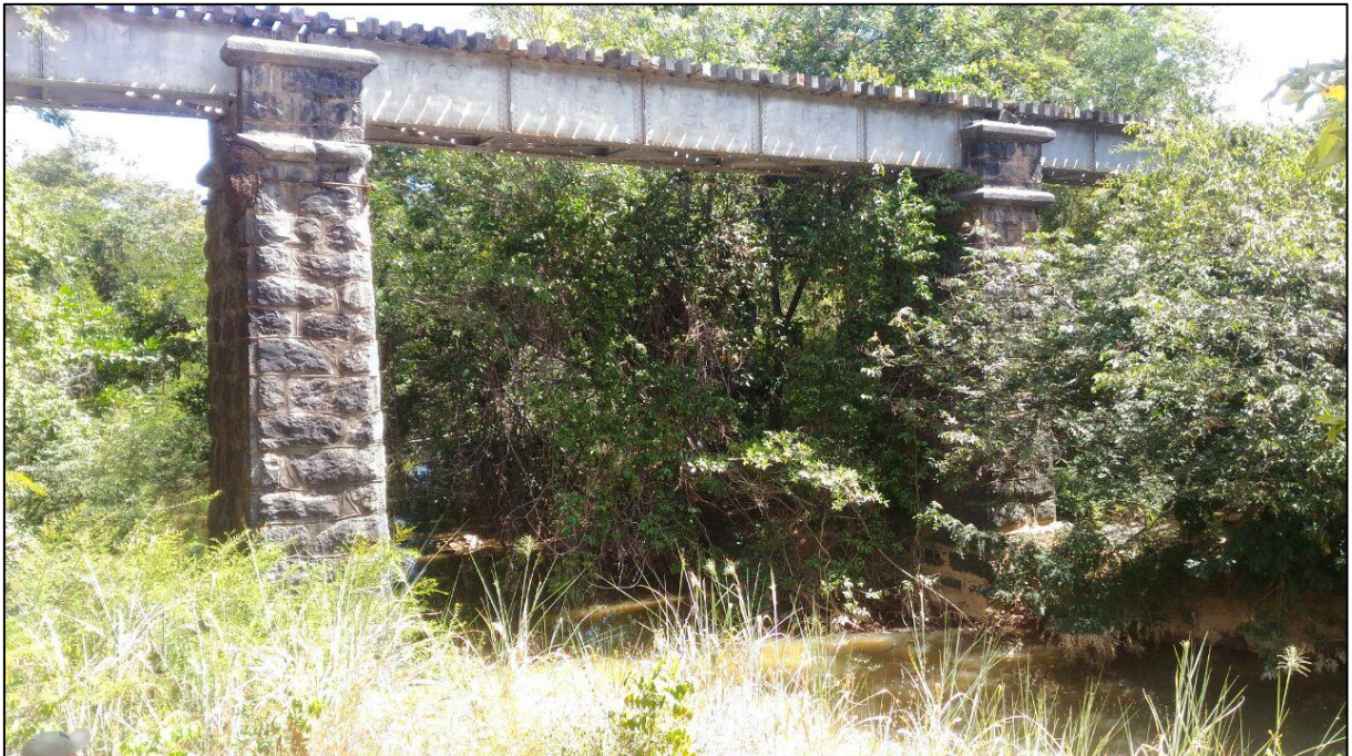
Figura 19. Ponte Centenária sobre o Ribeirão São Gonçalo das Tabocas. Fonte: LOCALMAQ, 2017.
