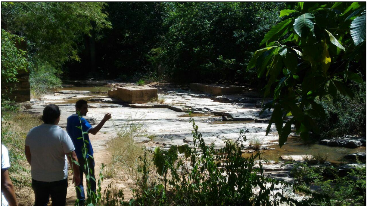
Figura 21. Reconhecimento do local das intervenções. Fonte: LOCALMAQ, 2017.
